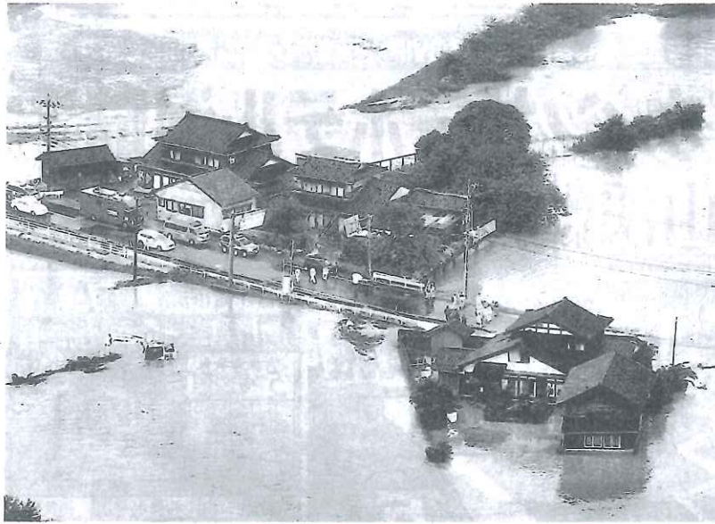
豪雨で川が氾濫した石川県輪島市門前町＝9月22日（ドローンから）
