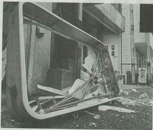
台風14号では、福岡県内でも強風の影響とみられる看板の落下などが相次いだ。9月19日、福岡市南区（撮影・星野崇）
