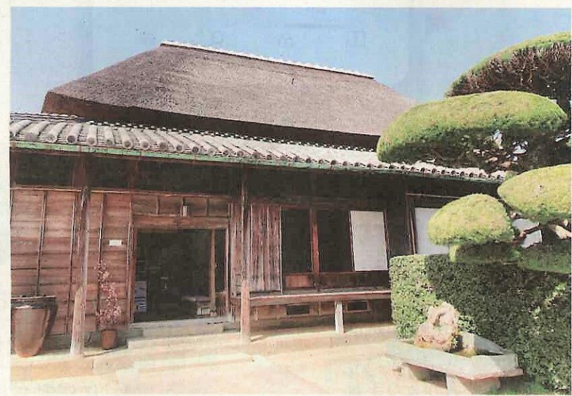
洪水時には屋根が救命ボートになる田中家住宅。自然との攻防が生んだ設計だ—石井町藍畑
